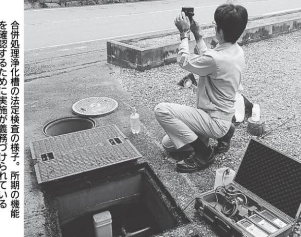
合併処理浄化槽の法定検査の様子。所期の機能を確認するために実施が義務づけられている
