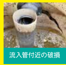
ばっ気槽の破損
