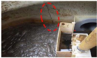
しかしながら、**老朽化が進み漏水等が確認された不適正な単独槽は年々増加**
